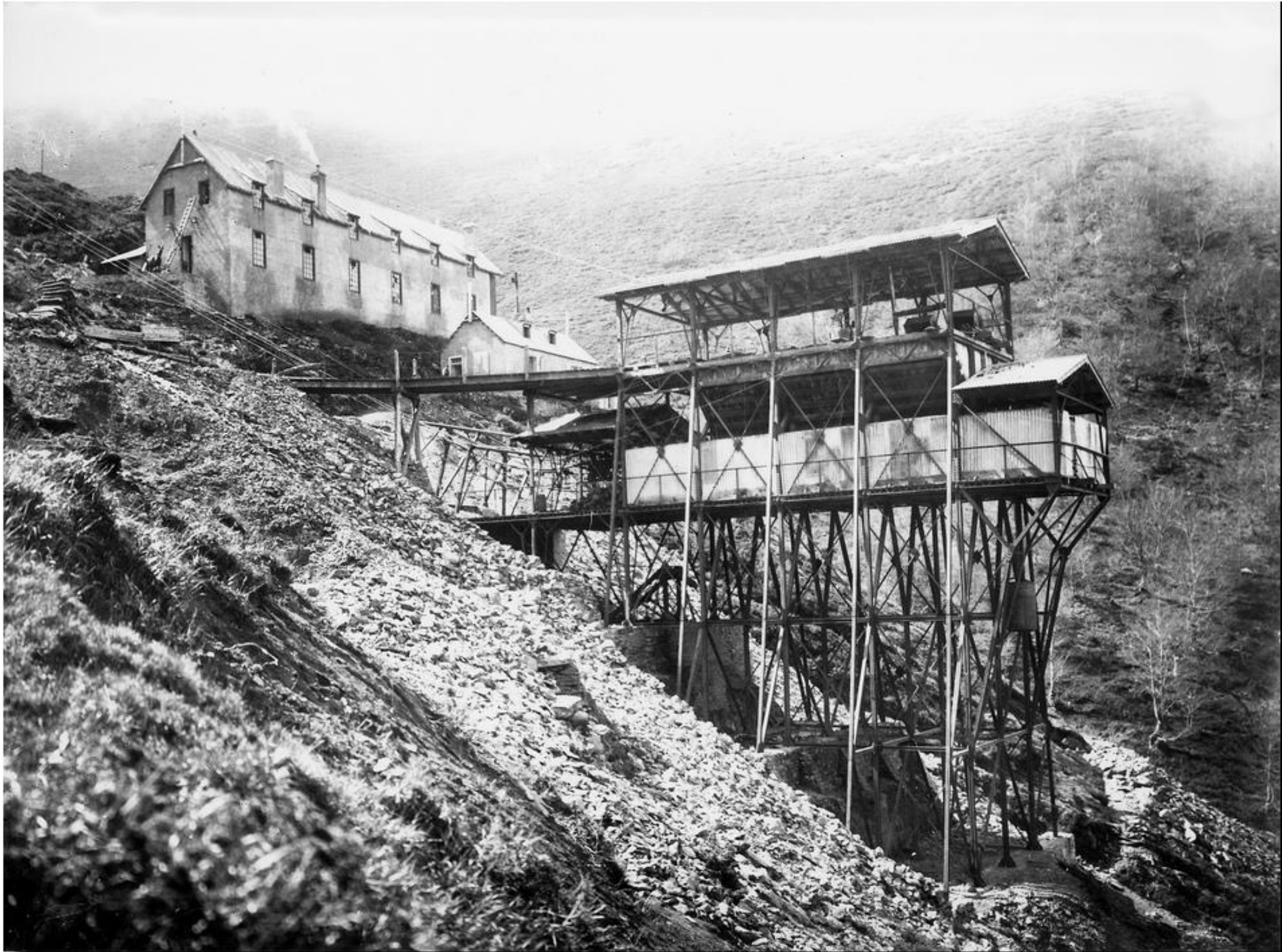
▶ station de chargement du câble – sortie du roulage principal à 1530 m (doc. Pierre Mancini)
