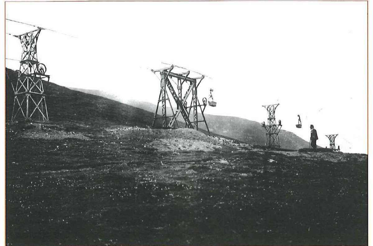
Ligne aérienne du transporteur par bennes (doc. M.D.)
