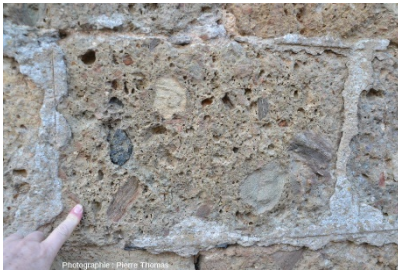
Brèche d'impact dans le mur d'une maison
